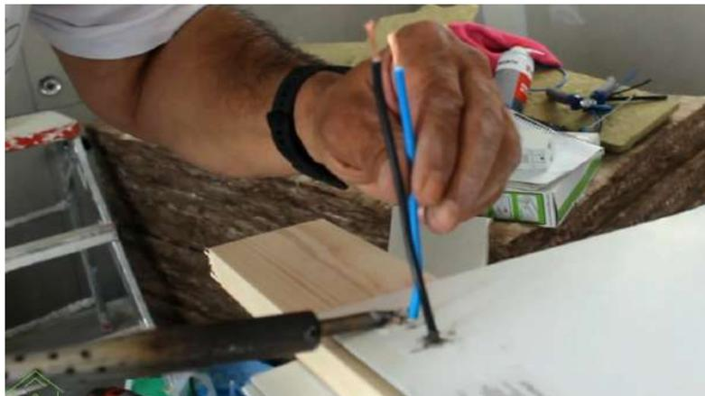
Después de las soldaduras, procedemos a la colocación de la placa. La placa debe ser colocada con mucho cuidado, de forma que quede pegada dentro del perímetro establecido, comenzando a pegar por un extremo de la placa.
