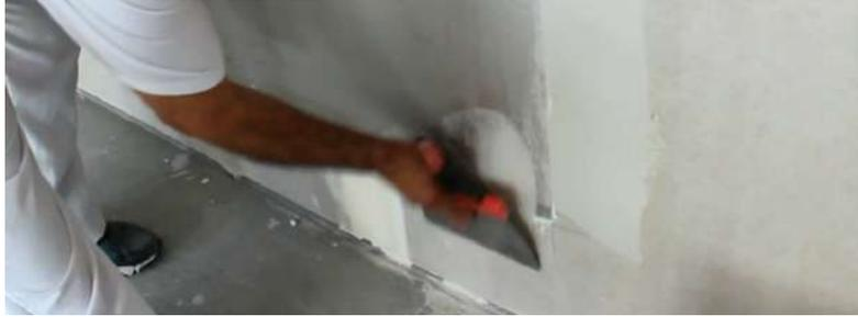
Una vez seca esta pasta, colocaremos cinta de fibra de vidrio entre la placa y la pared, siguiendo todo el perímetro de la placa. Esto sirve para absorber posibles dilataciones térmicas.
