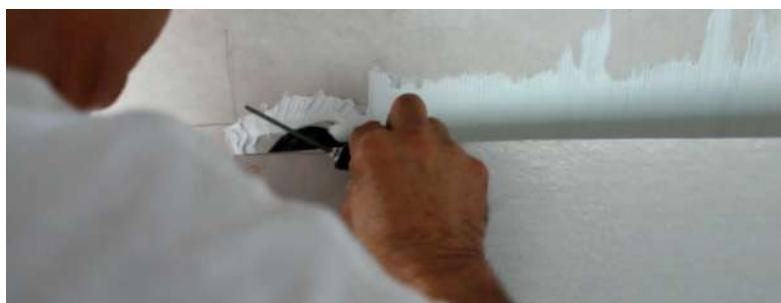
Después de estar correctamente ajustada, presionar toda la superficie de la placa con el fin de eliminar las posibles bolsas de aire entre la placa y la pared. La presión se debe efectuar en sentido horizontal a la colocación de la placa, por la zona más estrecha.
