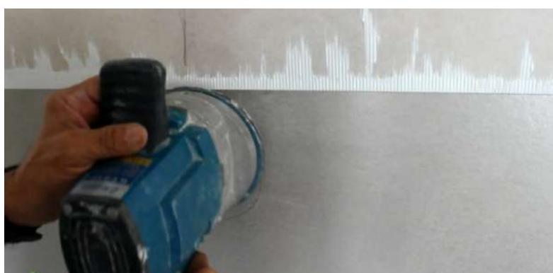
Como la máquina no presiona sobre el perímetro, sobre el perímetro se presión con un taco de madera, con los cantos romos, lo pasaremos por todo el perímetro para sacar el aire.
