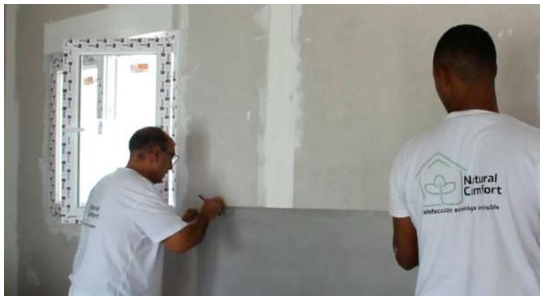
Después de señalar o marcar retiraremos la placa. En segundo lugar, se procederá a marcar la posición de la caja de conexión. Marcaremos a 6 cm a partir del vértice, tanto verticalmente como horizontalmente.
