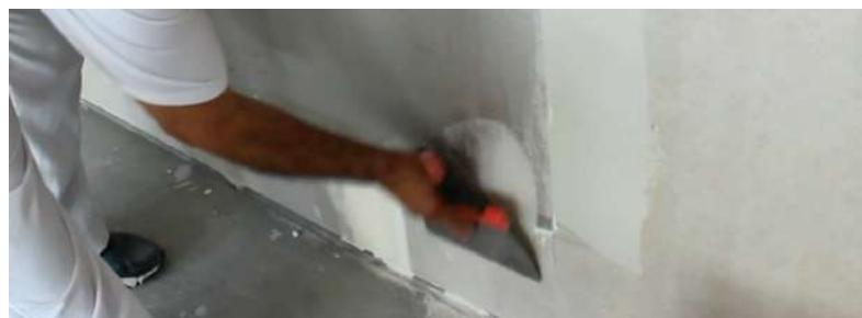
Una vez seca esta pasta, colocaremos cinta de Pladur entre la placa y la pared, siguiendo todo el perímetro de la placa. Esto sirve para absorber posibles dilataciones térmicas.
