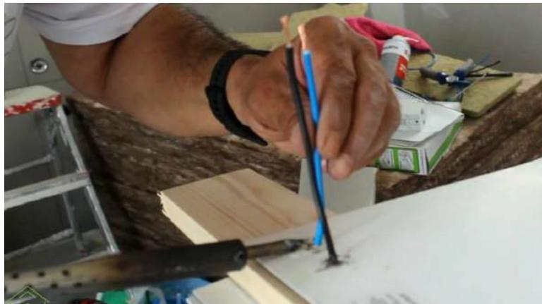
Ahora procedemos a la conexión de los cables de la placa, con los cables de la pared, con fichas de empalme homologadas. La placa debe ser colocada con mucho cuidado, de forma que quede pegada dentro del perímetro establecido, comenzando a pegar por un extremo de la placa.
